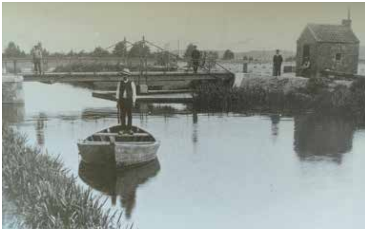
Verbleven brug 1 in Ossen met Brugscheiershuise. De Brugscheierswoning staat hier nog wel.
