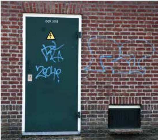
Graffiti op de deur en de muur van een transformatorhuisje.
