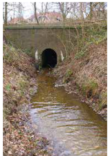
Het Gels Loopke gaat onder het station door.
