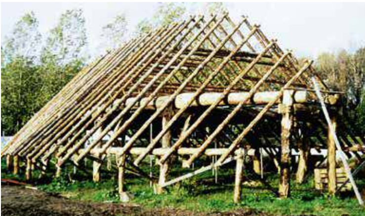
Constructie van een bootvormige boerderij.
