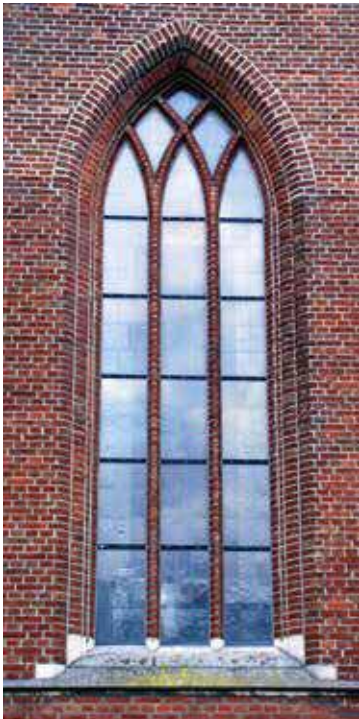
In baksteen uitgevoerde raamindeling.
