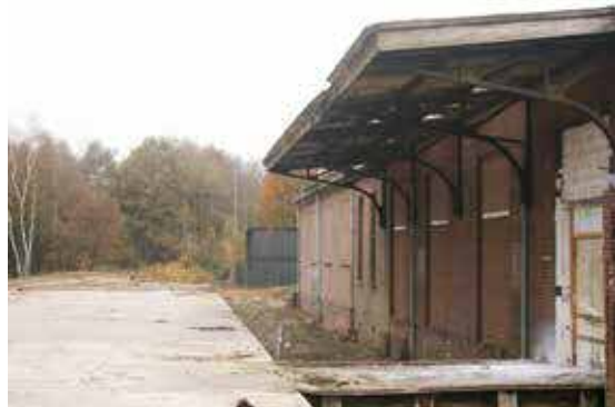
Het perron langs de goederenloods is weer zichtbaar.
