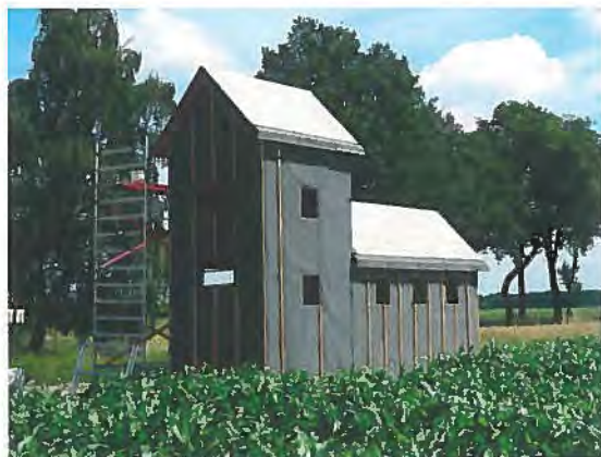
Gemeentewerklieden hebben de roofing bevestigd (foto Herman Janssen).
