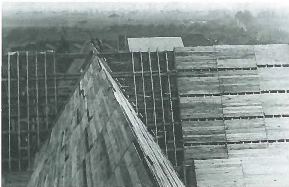
Stelselmatig wordt het dakbeschot op alle daken aangebracht.
