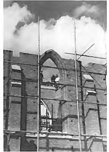
Afgebrokkelde en deels ingestorte muren worden netjes opgemetseld.
