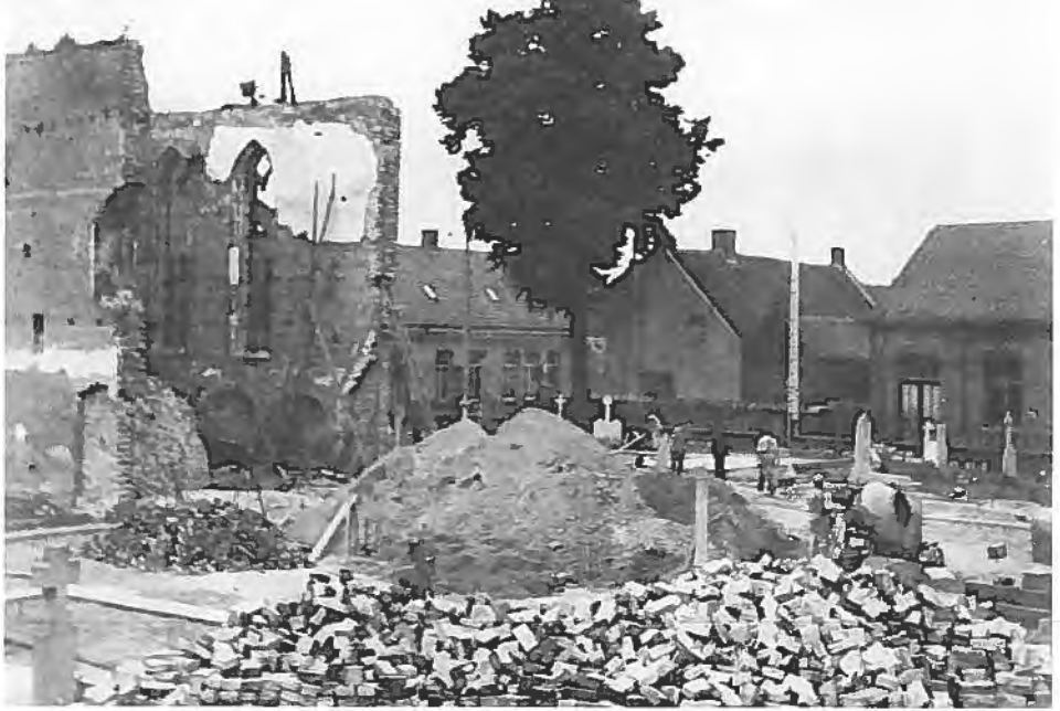
Na het puinruimen komt er overzicht en kunnen de werkzaamheden beginnen.
