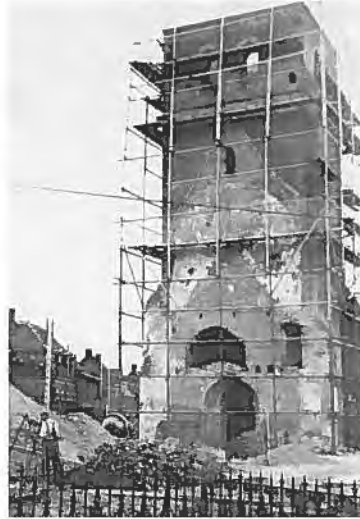
Zicht op de torenromp. De aansluitingen van dak, gewelf, oksaal en ingang tekenen zich duidelijk af tegen en in de muur.
