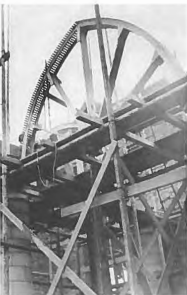
Waar nodig worden met behulp van houten mallen de raambogen opnieuw geconstrueerd.
