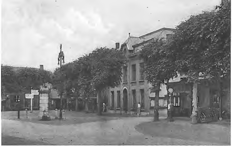
Een foto uit ca. 1930. Rechts met benzinepomp hotel den Engel, dan het gemeentehuis. Achteraan in de hoek is de smidse van de familie van Puijenbroek
