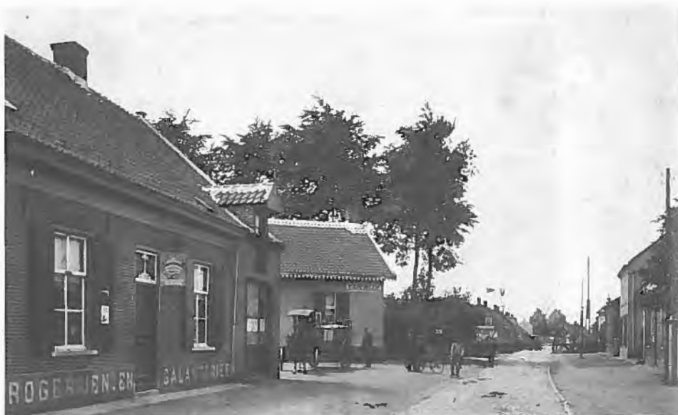
De Nieuwstraat, vlak voor de spoorwegovergang
