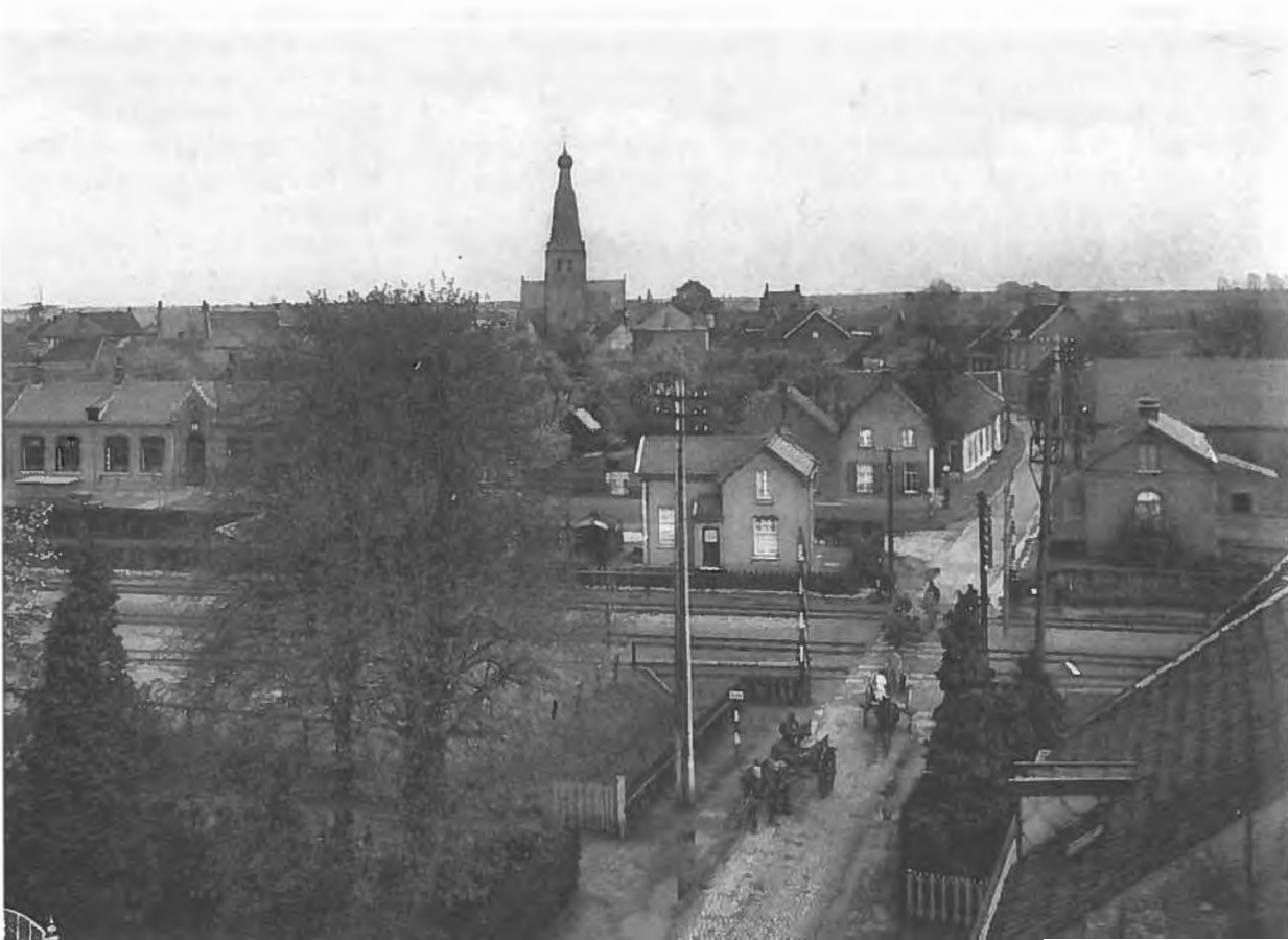
Spoorwegovergang Pastoor de Katerstraat met de Kerkstraat
