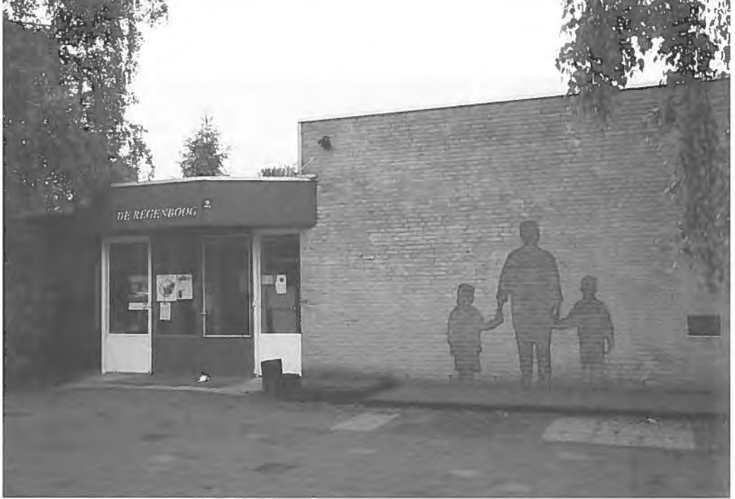
Het gedenkteken voor het werk van de broeders tegen een andere gevel van de gebouwen.
