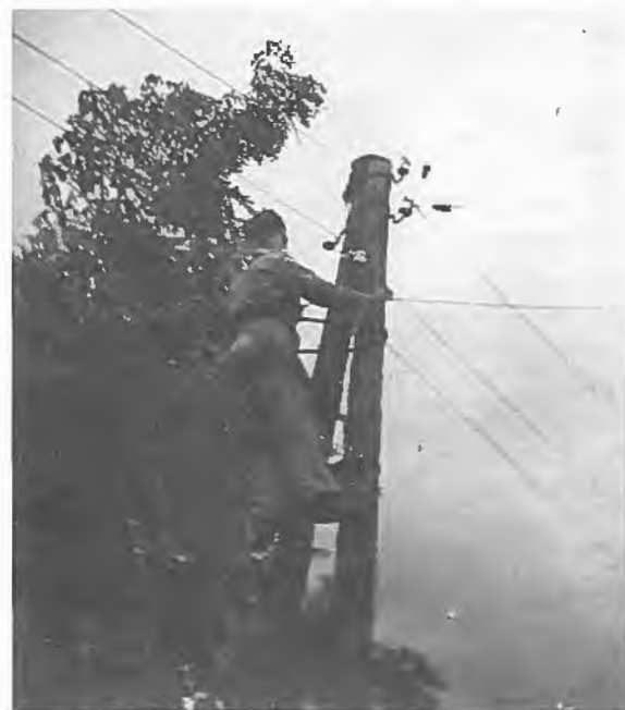
Frans in 1962 aan het werk in een elektriciteitspaal in Baarle
