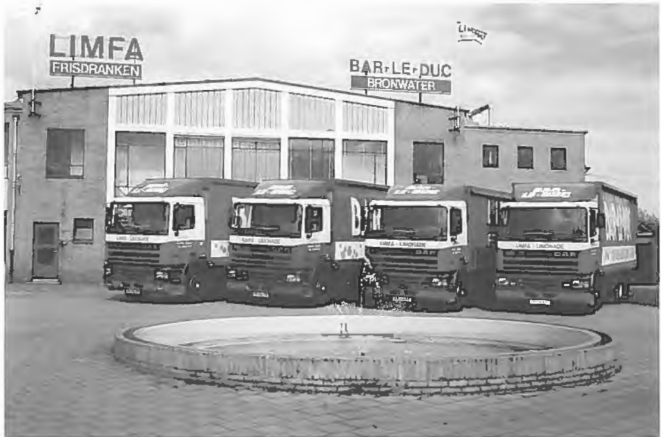
Het vooraanzicht van een gedeelte van de fabriek
