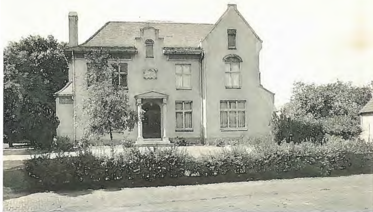
Op dezelfde plaats werd in 1943 de nieuwe woning en praktijkruimte gebouwd
