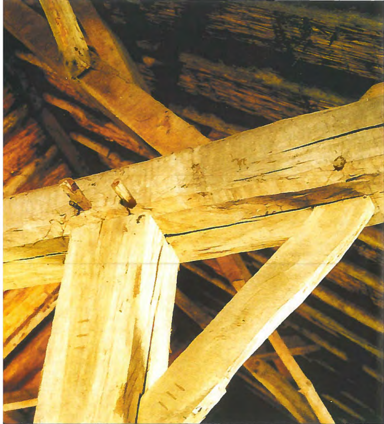
Deel van de houten constructie van een Vlaamse schuur, zoals die door de monniken ontwikkeld is.
