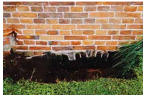
De buitenmuren steunen op bogen.
