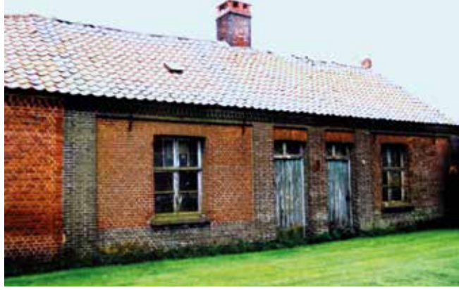
De boswachterswoning aan de Haldijk in Ulicoten.
