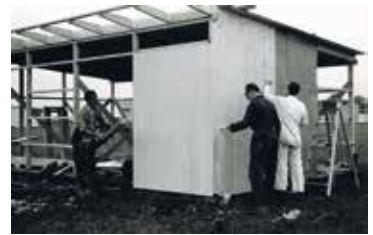
De bouw van de huisjes.
