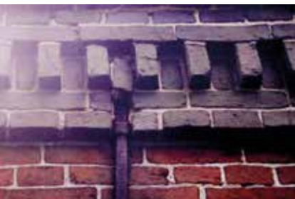
Verzorgd metselwerk in rode en zwarte baksteen.
