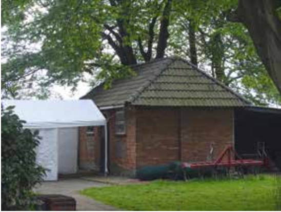
C87 Het Klompenhuisje in april 2018.
