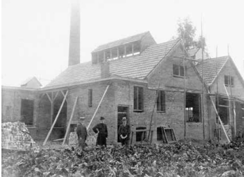
De fabriek van de Coöperatieve Stoomzuivelfabriek 'de Hoop' in aanbouw.
