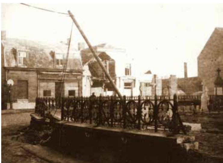
Meerdere ingestorte huizen. collectie Bidoc
