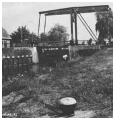
Brug in Someren bij Sluis 11.
