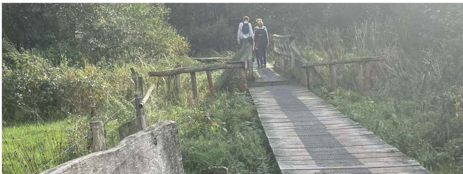
Vlonderbrug over het beekdal van de Oude Leij
